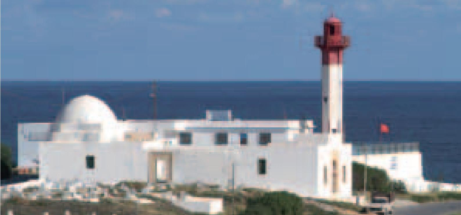
Le phare de Sousse émerge des remparts de la Casbah sur une tour de 22 mètres qui date de 1890. Il émet un éclair blanc toutes les dix secondes avec une portée de 22 nautiques.
